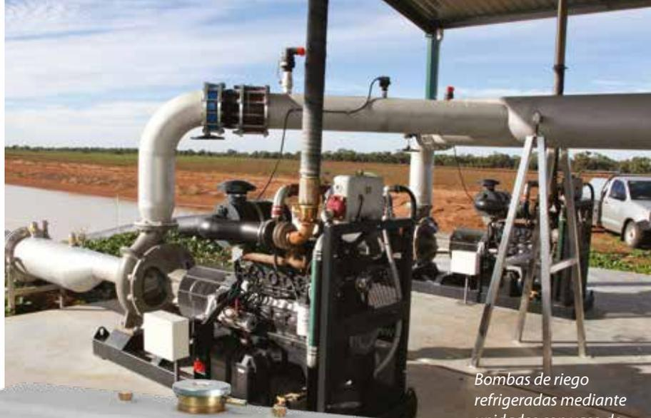
*Bombas de riego refrigeradas mediante unidades con vaso de expansión Bowman en Australia*
